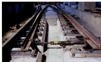
Weichenzungenvorrichtung mit Kölner Ei®
