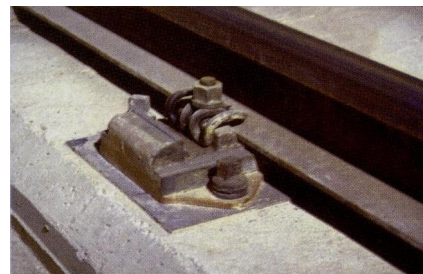
Alternative I, Typ '025 auf Betonuntergrund
